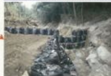
導流工が完成(7/24)
