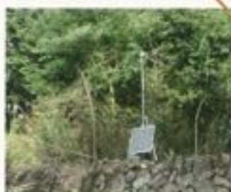
監視カメラ設置完了(7/28)
