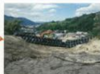
導流工が完成(7/22)
