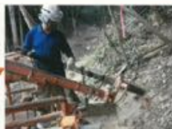
アンカー工(ワイヤーネット)の促進
