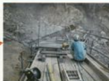
アンカー工(ワイヤーネット)の促進
