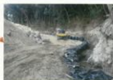
流路工が完成(7/23)
