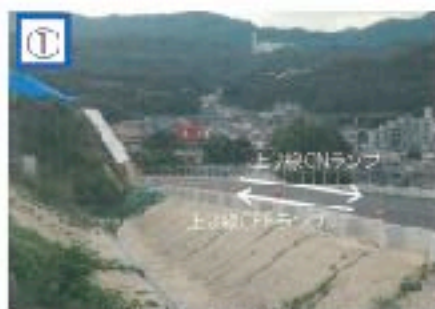
軽量盛土工(上り線)
