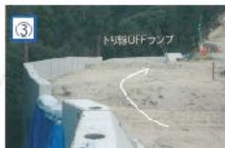
補強土壁工(下り線)
