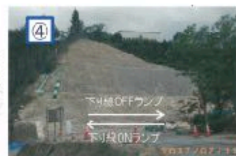
切土工(下り線)
