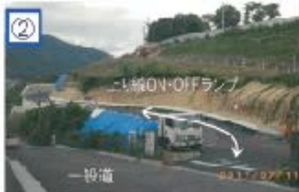
補強土壁工(上り線)
